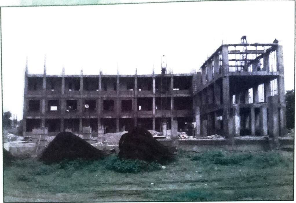
महाविद्यालय के निर्माणाधीन भवन का एक दृश्य
